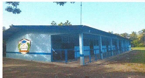
Foto 4: TRABAJO FINALIZADO Y ALUMBRADO COMPLETO
