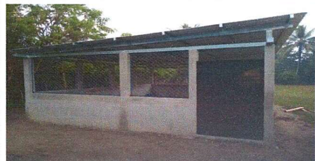
Foto 5: LA COCIMA QUEDANDO DE ESTA MANERA CON ESTRUCTURA METALICA AL 100
